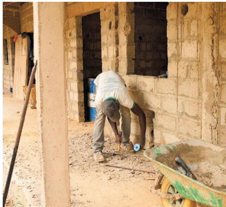
Bouwwerkers aan het werk aan het safehouse: een eenvoudig, functioneel gebouw en tegelijk een paradijs.
